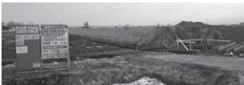
(仮称) 当別町道の駅載荷盛土の様子
