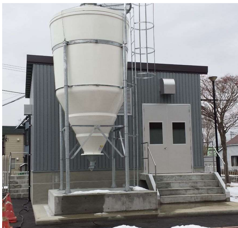
総合体育館のボイラ棟
