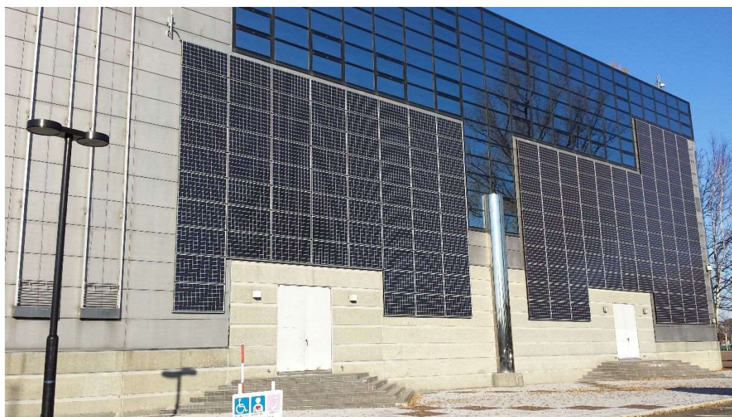
総合体育館に設置した太陽光パネル
