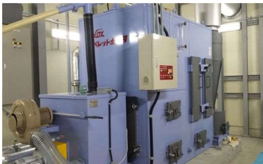
総合体育館のペレットボイラ外観
