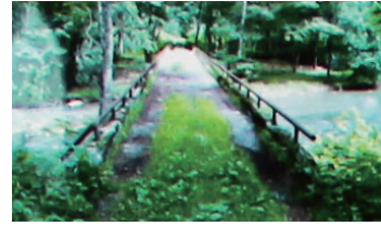
大袋停留所 付近の橋梁
