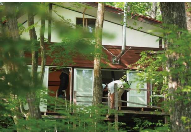
空き家をリノベーションしている様子(本人提供)
