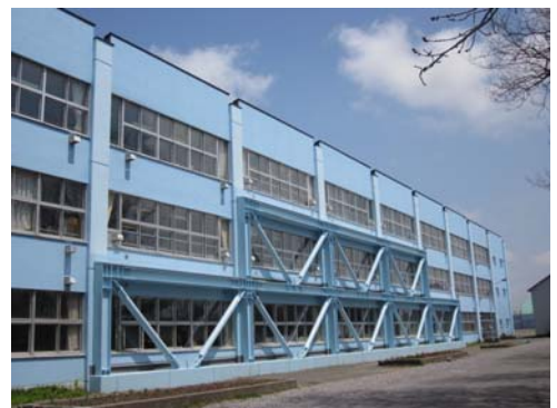
(耐震改修工事後の当別小学校校舎)
