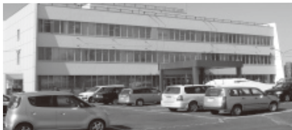
築42年が経過している役場庁舎
