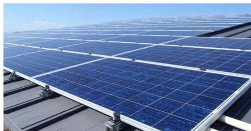
ソーラーパネル設置の例
