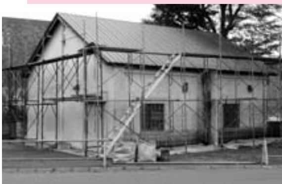
修繕される役場書庫
