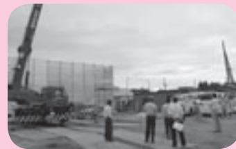
建設中の子ども発達支援センター
