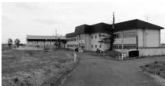
中小屋地区の避難所に指定されている旧中小屋中学校
