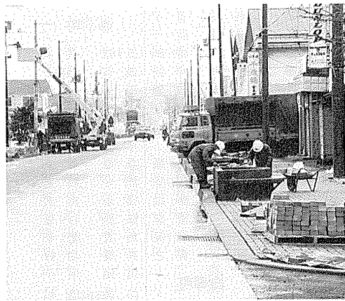
▲マイロード事業に選定 北欧風の道路整備を目指す、町道スウェーデン大通線が、建設省の「マイロード事業」に選定され、今年はカラーブロックの歩道や車道約320mが完成した。
