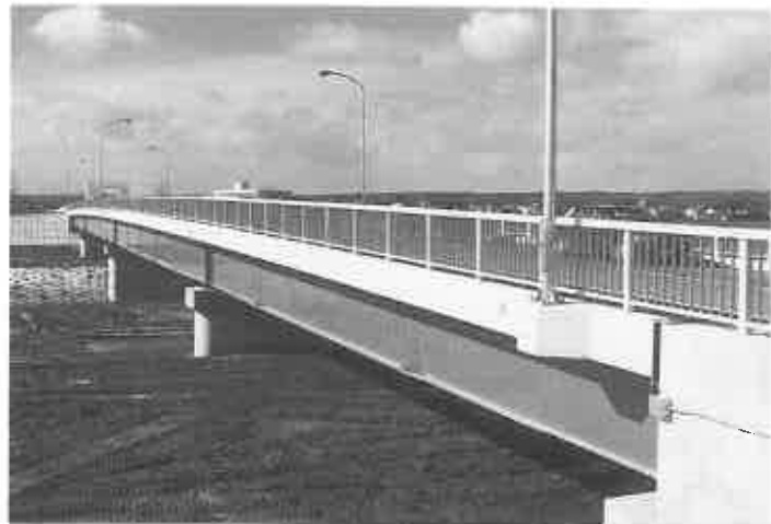
▲旧金沢橋上流150メートルに新設された金沢橋
