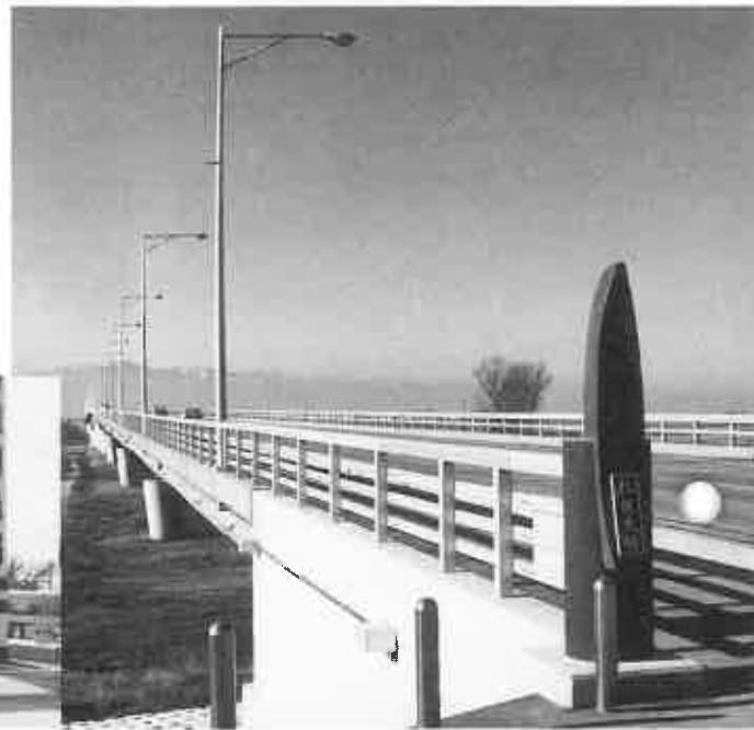
▼札幌大橋開通 当別町と札幌市を直結する札幌大橋の開通式が8月10日行われました。同橋は、8年の歳月と約70億円の工費をかけ、上下各一車線の全長985.3メートルの道内では2番目の橋として誕生しました。
