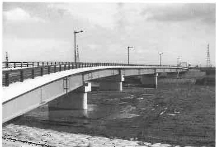
▲道道札幌・当別線の交差点から川下左岸へ通じる南1号橋
