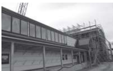
道の駅の外観
