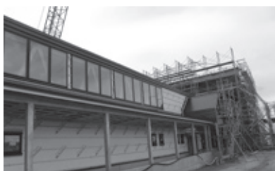
道の駅の外観
