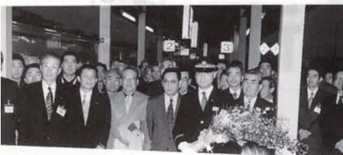
JR 学園都市線 新石狩川橋りょう完成
