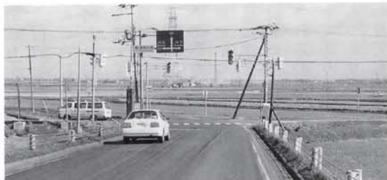
危険箇所の早急な安全対策が必要である
