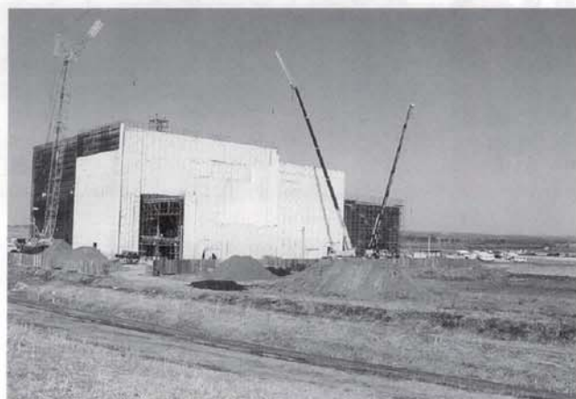
現在、建設が進んでいる江別市新焼却施設
