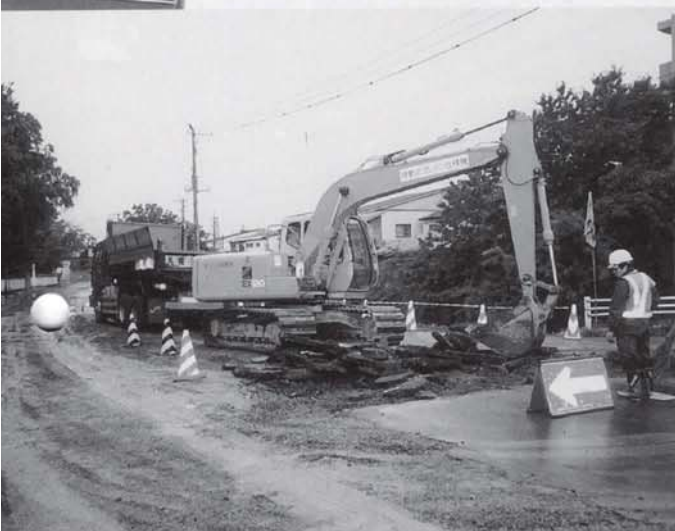
北栄通の工事の様子
