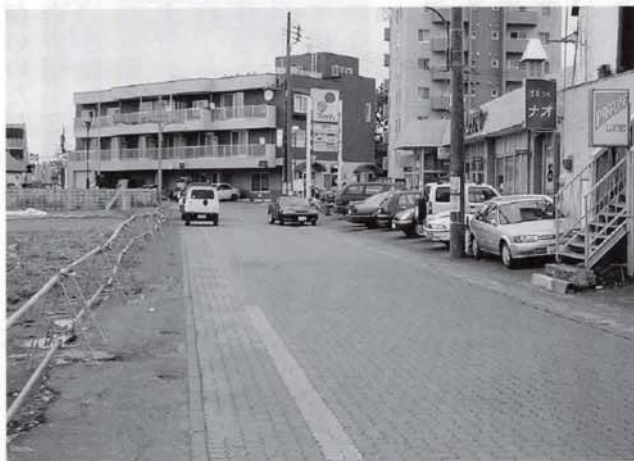
道路改良が求められるフレッティ前の道路
