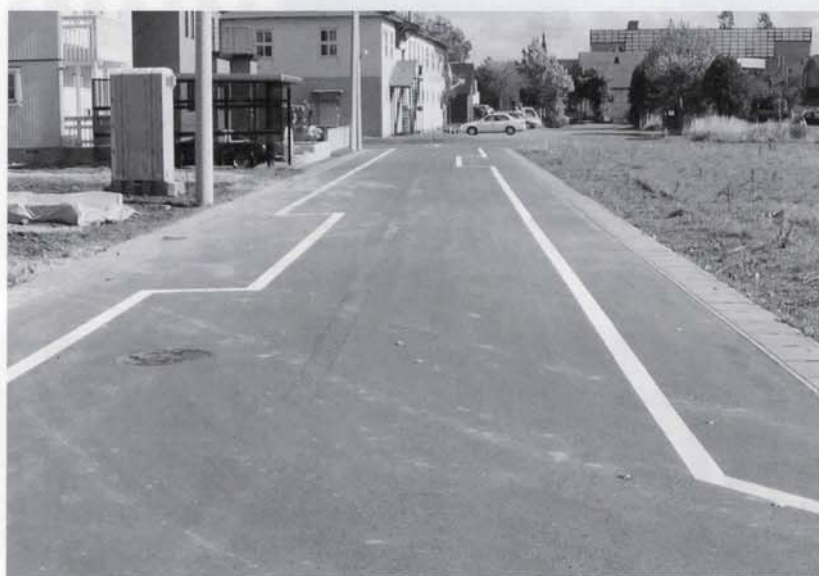
区画線による1.5車線道路
