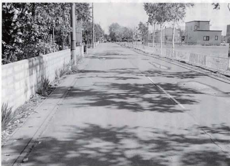
歩道整備がされていない町道
