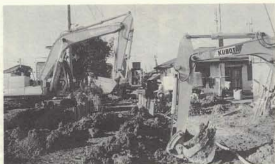
道路工事現場
