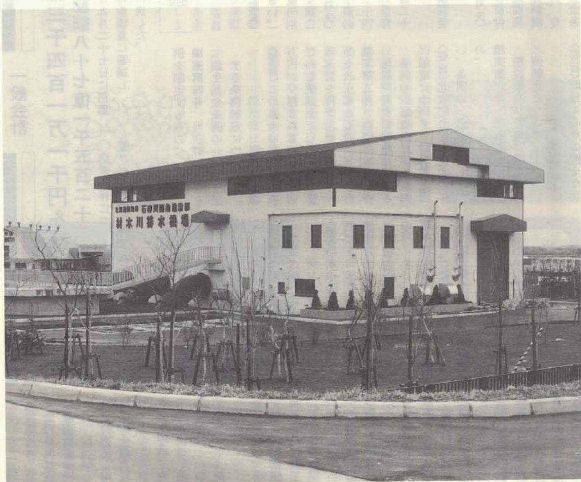
完成した材木川内水排除機場
