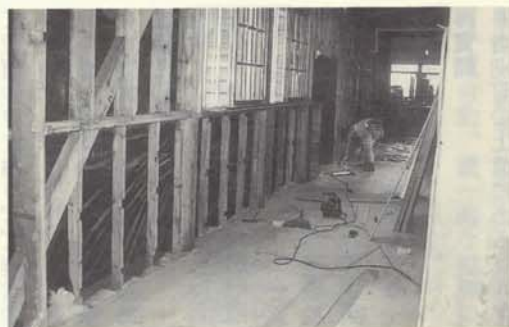
木造校舎の改修工事
