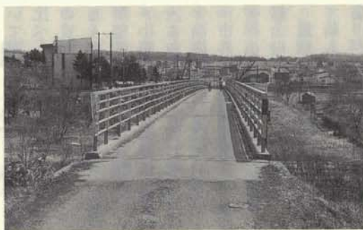
弁華別学校橋の早期改修を
