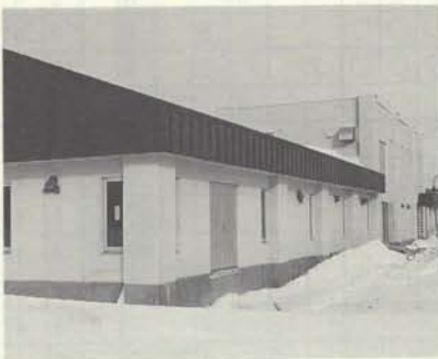
〈増設が進む太美町汚水処理センター〉
