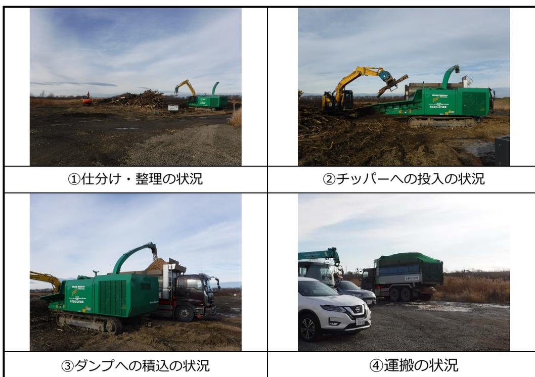
写真 6-1 河川支障木のチップ製造作業状況
