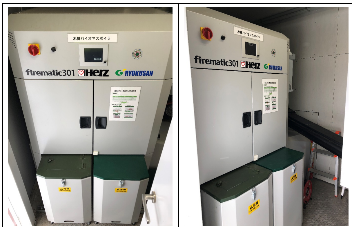
写真 9-1 導入した木質チップボイラ
