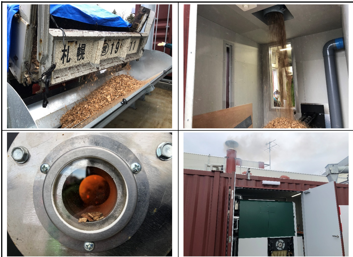
写真 9-2 ボイラ燃焼試験の状況（令和2年11月21日撮影）
