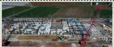
校舎建設現場（5.18撮影）
