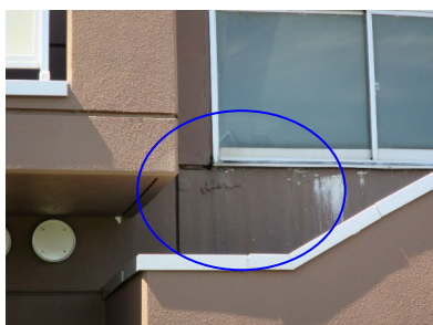
新春日団地94-1 (2号棟) 摩耗、ふくれ、剥がれ (劣化デグリー-3が20%未満)
