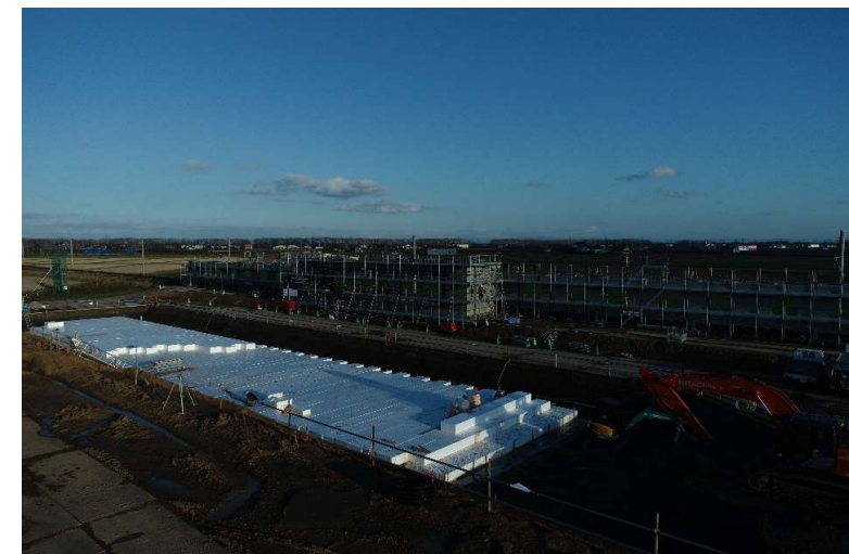
駅舎・広場 全景（地上から）
