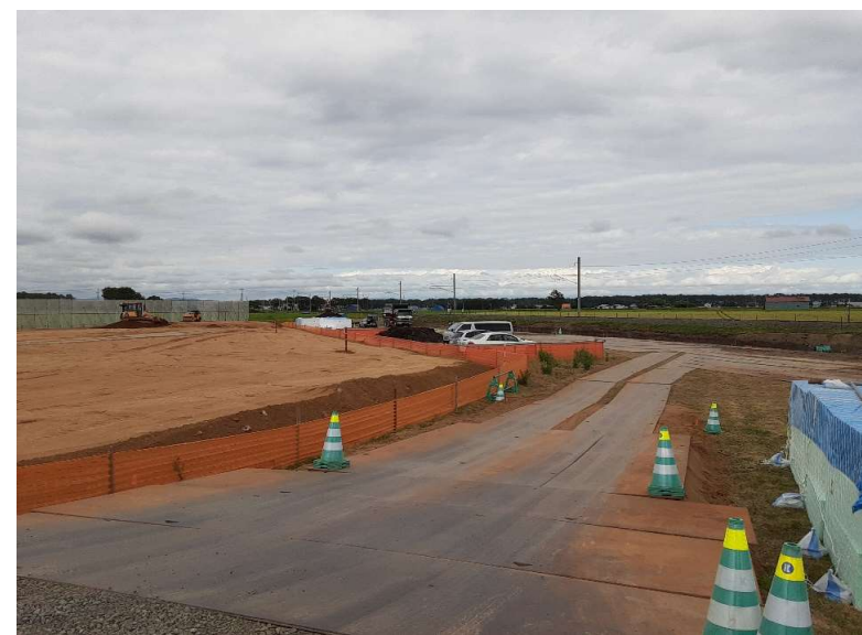
駅前広場 全景（地上から）
