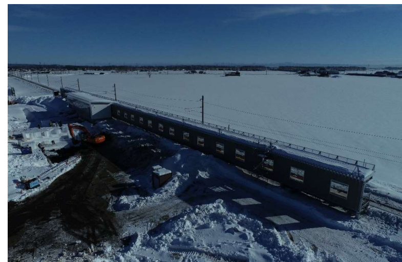
駅舎・ホーム 全景（低空から）
