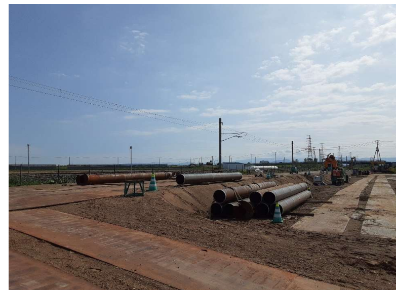
駅前広場 全景（地上から）
