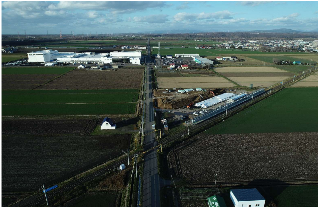
ロイズタウン駅 周辺（上空から）
