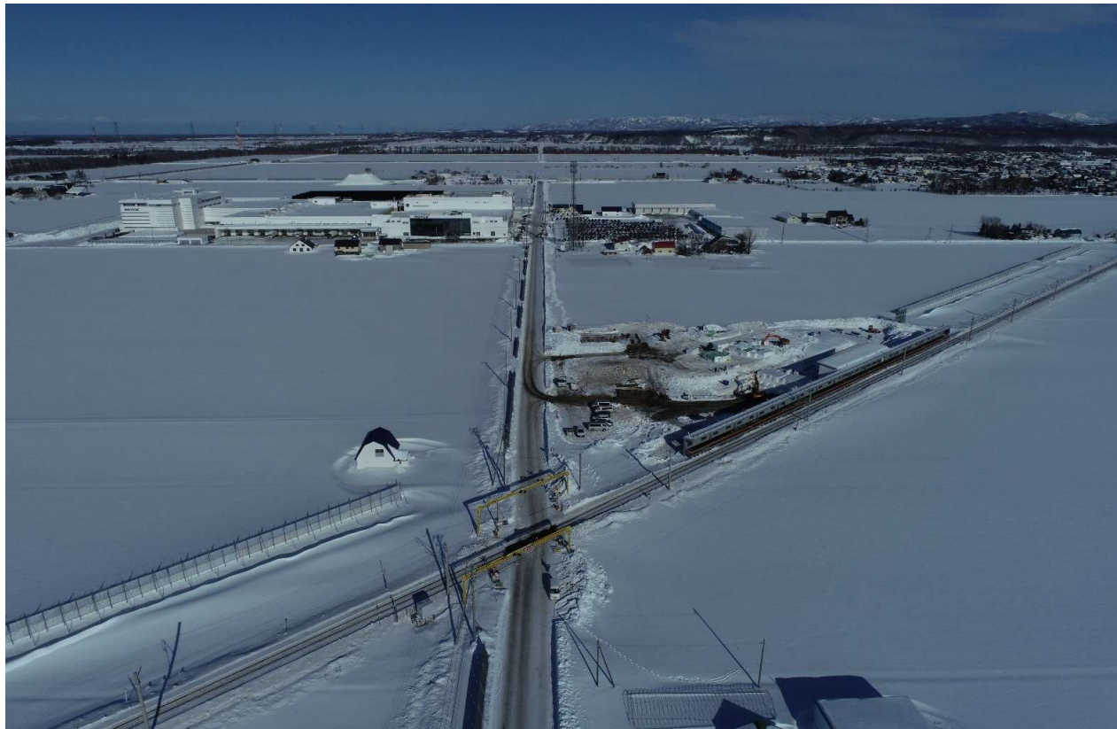
ロイズタウン駅 周辺（上空から）
