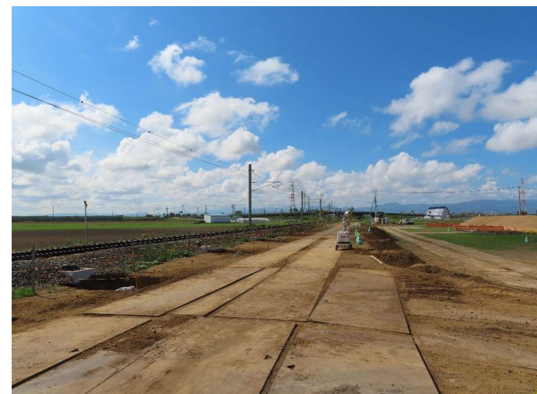
駅前広場 全景（地上から）
