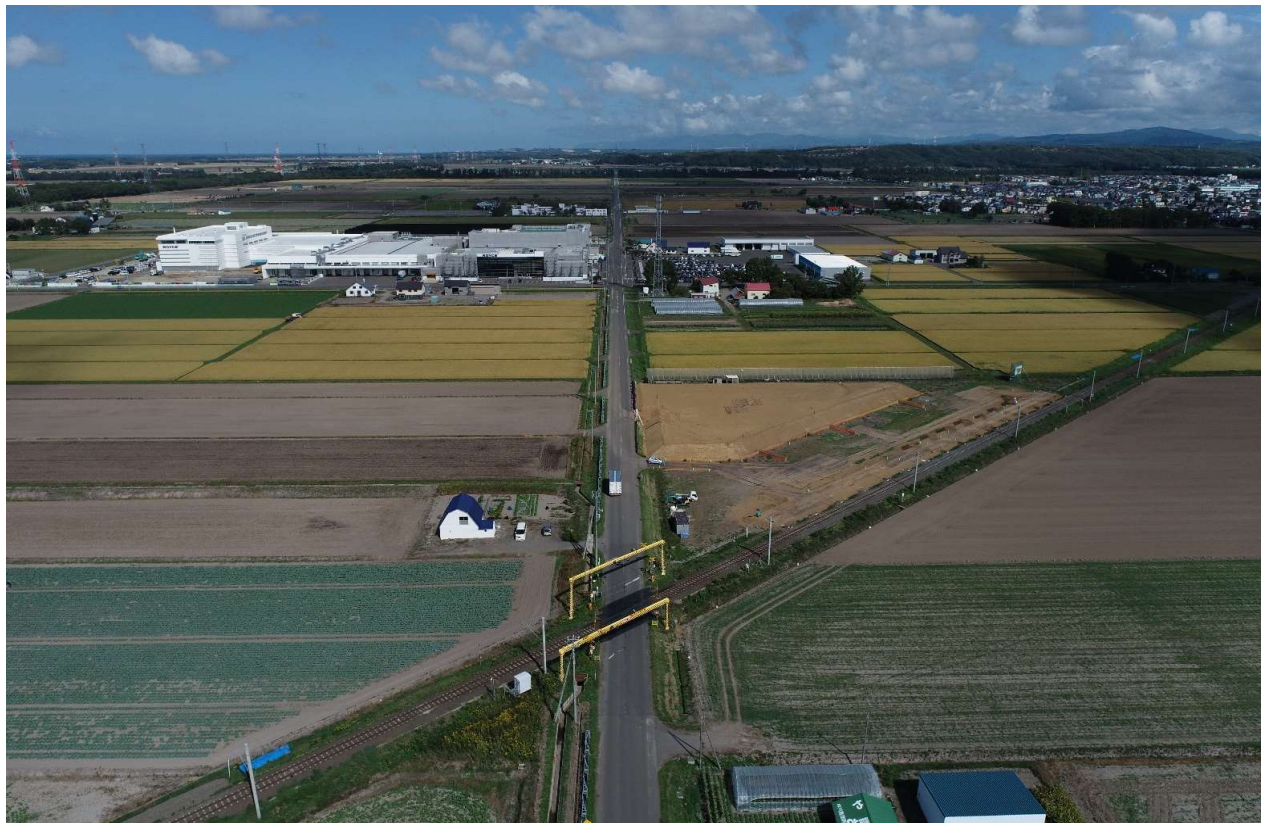
ロイズタウン駅 周辺（上空から）
