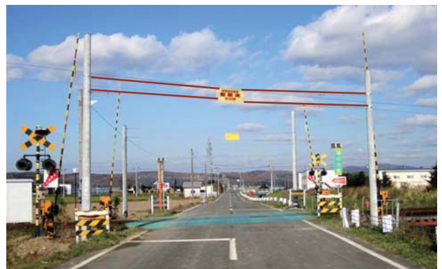
踏切の高さ制限標 スパン線式（中央排水路踏切）
