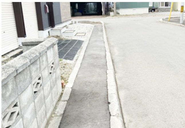
修繕された歩道
