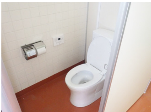
改修されたトイレ（西当別小学校）
