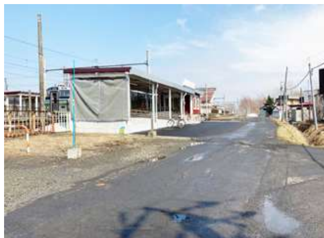
太美駅南側の町道
