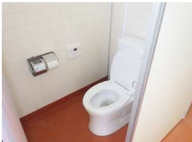
改修されたトイレ（西当別小学校）
