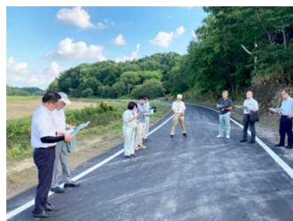
町道中小屋線（中小屋）
