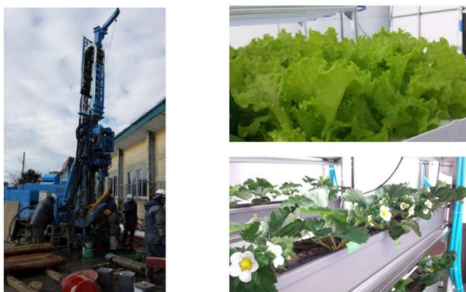
写真 1 地中熱を活用した栽培実証事業
