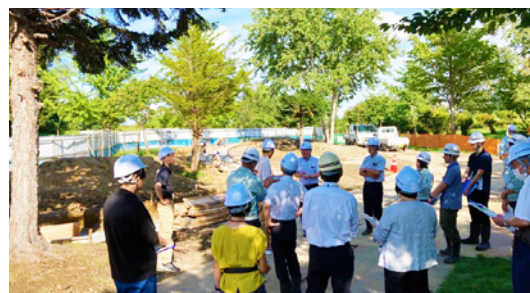
阿蘇公園施設更新工事 視察の様子
