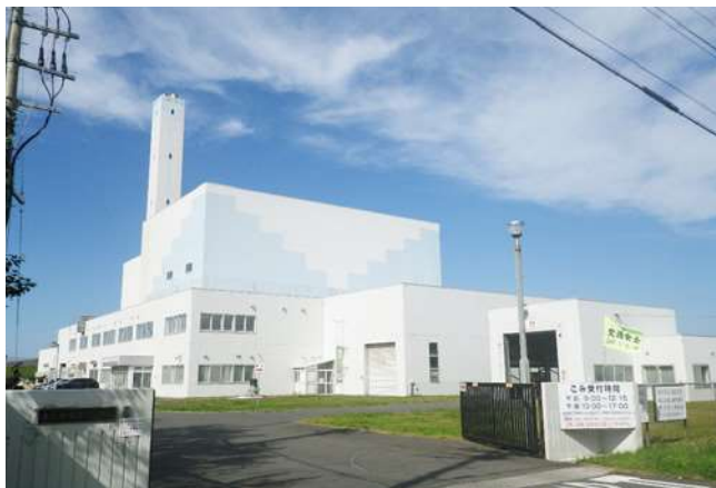
北石狩衛生センター（石狩市提供）
