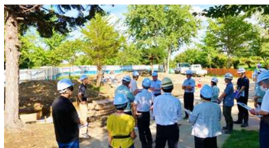
阿蘇公園施設更新工事 視察の様子
