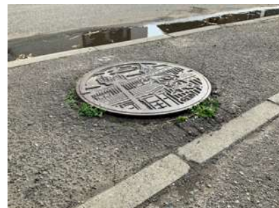
地盤沈下でマンホール部分が段差に
