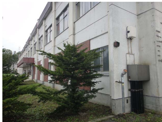
植栽樹木右手の窓より設備撤去・搬入
