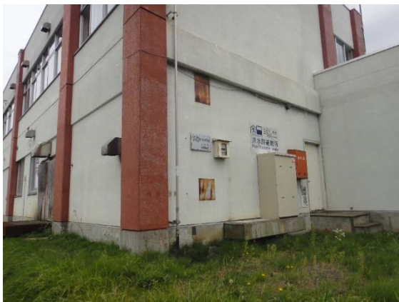
ボイラー室に位置する壁面
