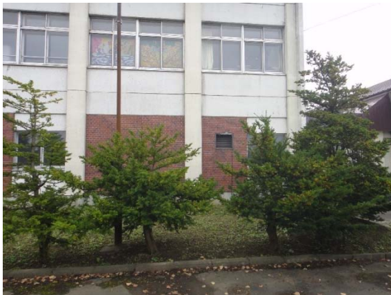
旧館ボイラー室に位置する壁面
