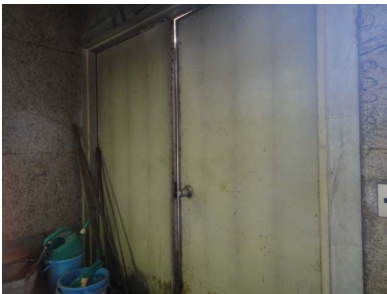
ボイラー室扉（設備撤去・搬入口）
