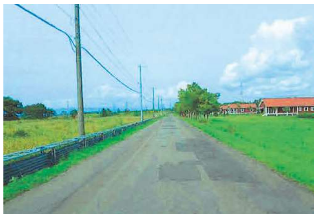
改修工事前の町道高岡中央線
