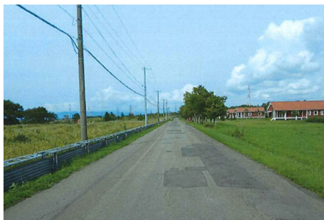
改修工事前の町道高岡中央線
