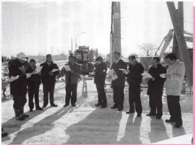
当別幸町土地区画整理事業 ・当別大道路改良工事
