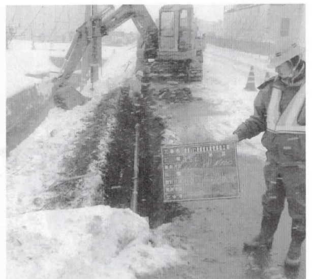
町道32線南4号 布設状況
