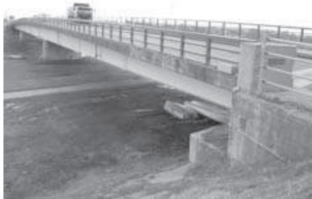
大型車の通過とともに春風が舞う当別大橋
