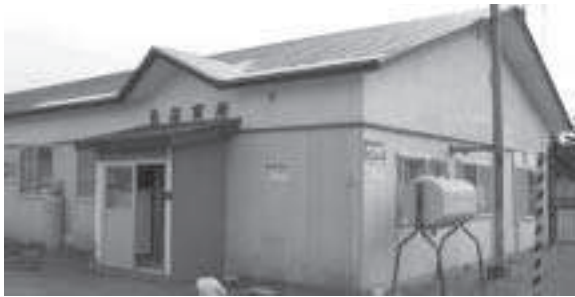
北保育所 (昭和四十五年建設)
