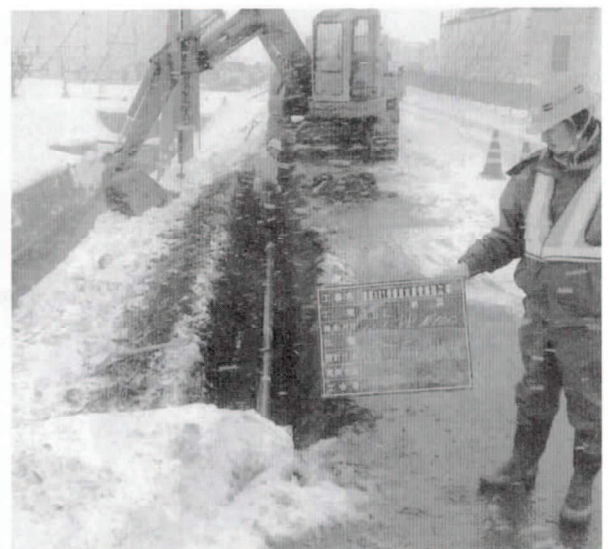
町道32線南4号 布設状況
