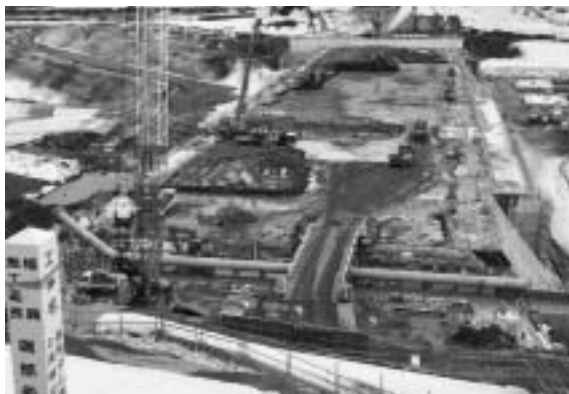
着々と工事が進む当別ダム (4月7日現在)
