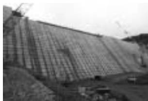
着々と進んでいるダム工事
