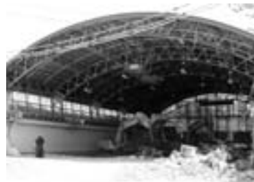
解体中の当別小学校体育館
