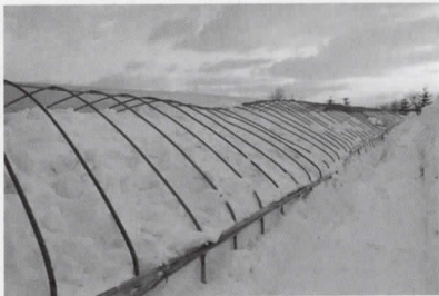
大雪による被害をうけたビニールハウス
